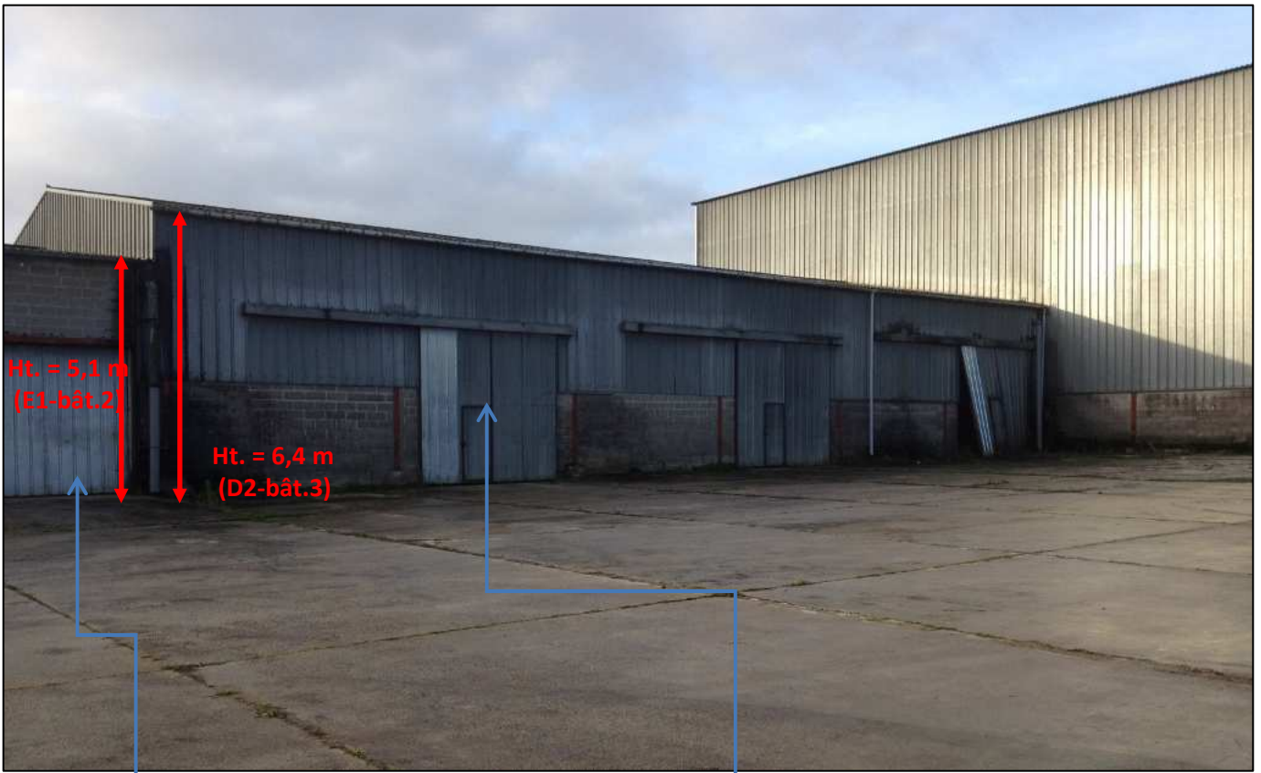
Hall de stockage E1 (bâtiment 2)
